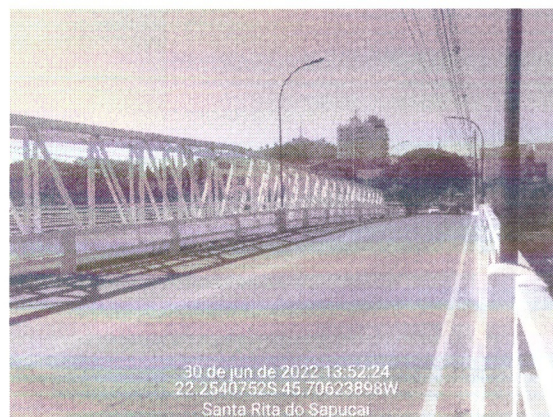
Figura 5 - Ponte e passarela metálica
