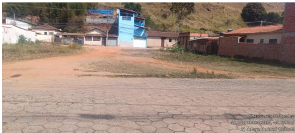
Figura 1 – Local da Construção
