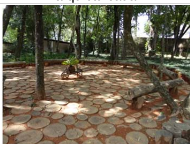
Ex. 1 de cobertura utilizada para elevar o piso e permitir a infiltração da água
