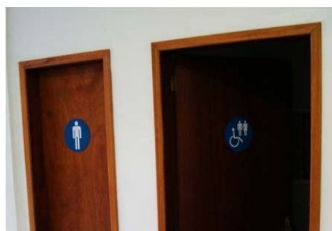
Exemplo 2 de Sinalização de Edificações
