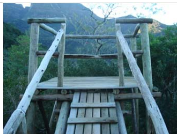
Exemplo de Torre para Observação
