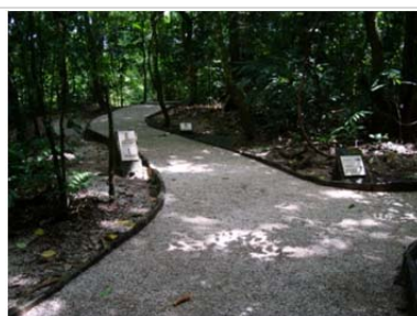
Ex. 2 de cobertura utilizada para elevar o piso e permitir a infiltração da água
