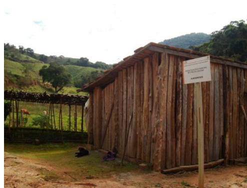
Figura 96 - Estrutura rústica de almoxarifado
