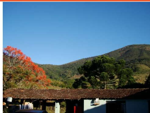
Figura 83 - Exemplo de residência rural em São Sebastião da Bela Vista
