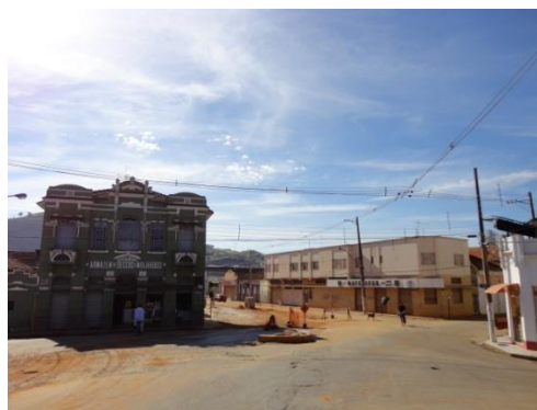
Figura 74 - Destaque para obras de saneamento e manejo de águas pluviais em andamento
