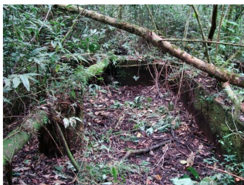
Figura 86 - Antiga canalização de ferro e estrutura de caixa d'água no interior da Reserva Biológica Municipal
