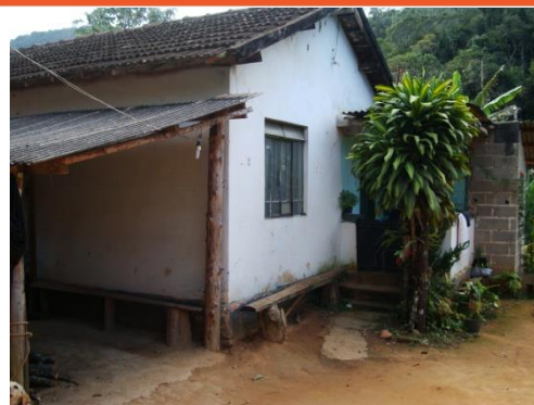
Figura 107 – Detalhe da Casa no interior do Parque Municipal aonde reside o funcionário com sua família.
