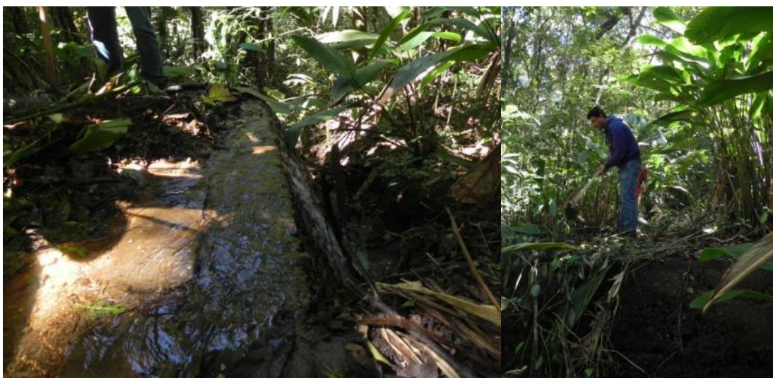
Figura 6 – Reservatório 2 inteiramente assoreado e recoberto por vegetação higrófila.
