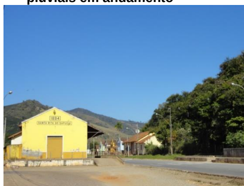
Figura 76 - Estação Ferroviária desativada em Santa Rita do Sapucaí (Abriga Secretaria Municipal)
