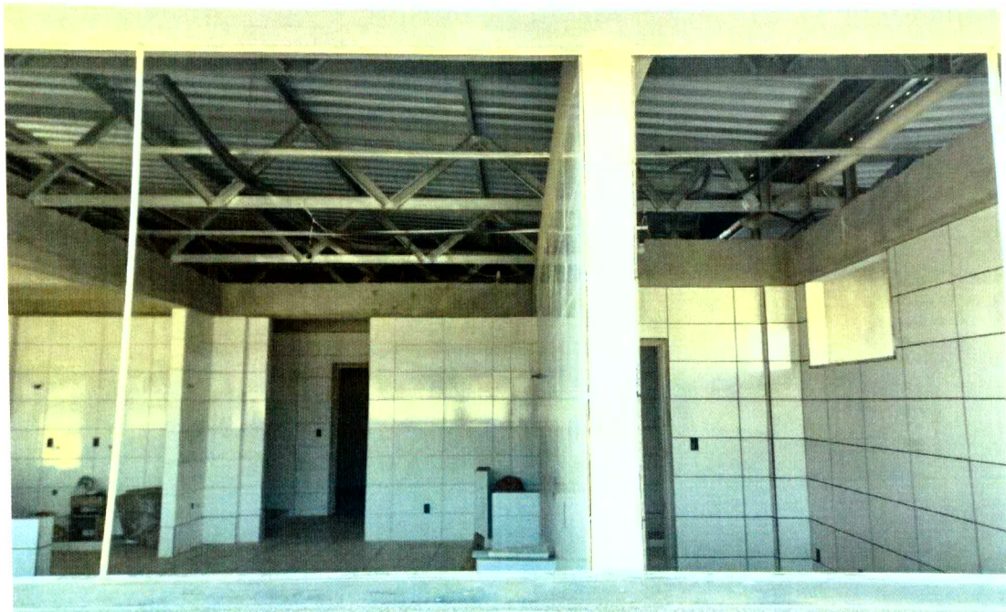
FOTO 21 - VISTA DA COZINHA
