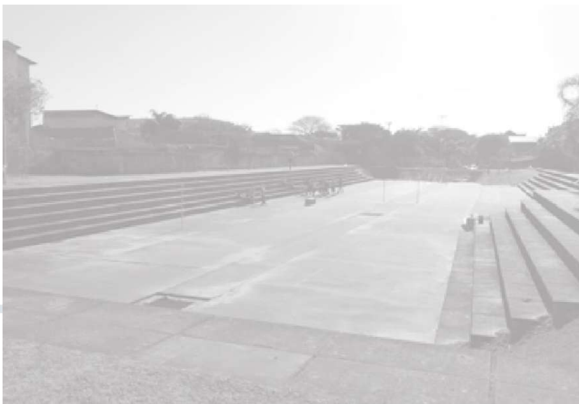
Figura 3 - Reservatório de detenção Fonte: ABCP
