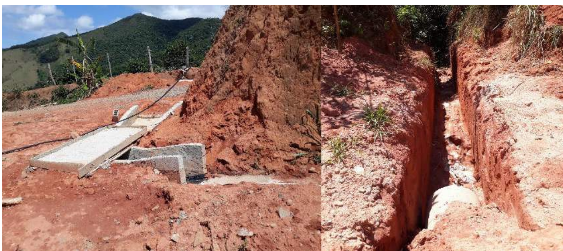
Figura 221 – Estruturas de drenagem na estrada rural de Santa Rita do Sapucaí, MG
