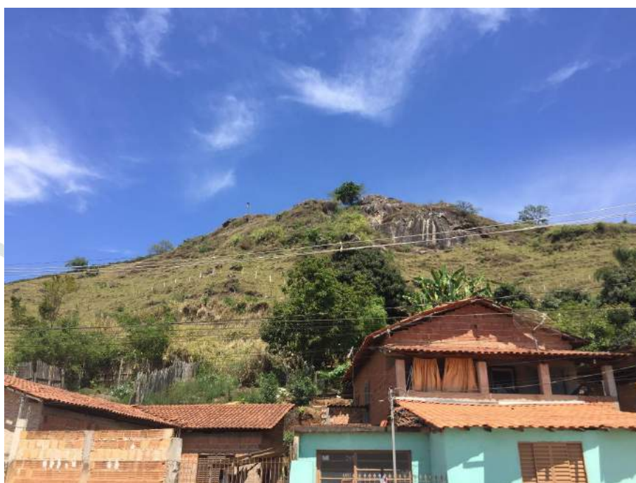
Figura 203 – Área de risco 1 em Santa Rita do Sapucaí
