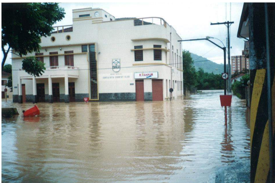
Figura 159 - Evento de inundação gerado pela chuva no ano de 2000 - Região da Praça Santa Rita em Santa Rita de Sapucaí.
