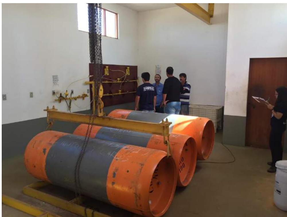
Figura 77 – Casa de cloração Fonte: Próprios autores, 2019
