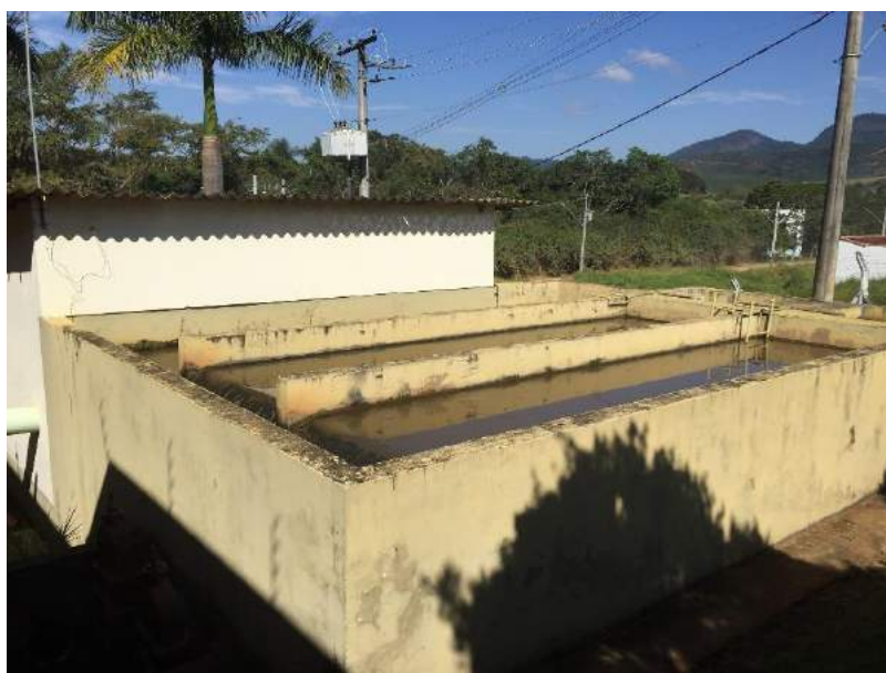
Figura 73 - Tratamento primário com desarenador
