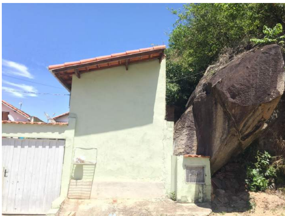
Figura 211 – Área de risco 5 em Santa Rita do Sapucaí
