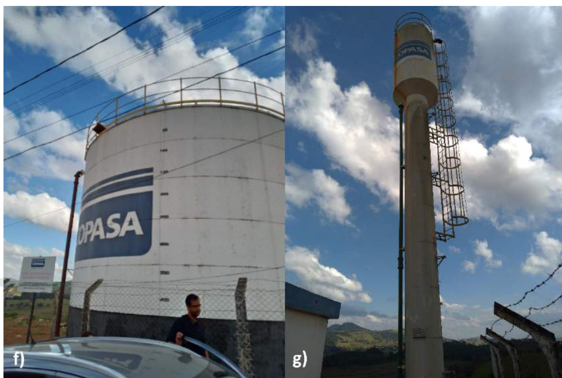
Figura 91 – Vista para os reservatórios em Santa Rita do Sapucaí. f) R11, g) R12 Fonte: Próprios autores, 2019
