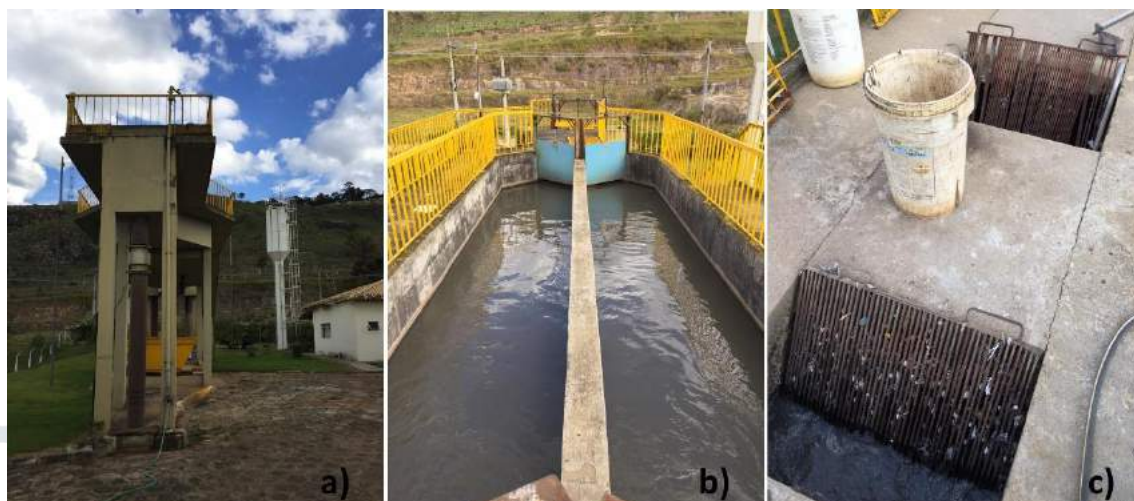
Figura 103 – Gradeamento e desarenador. a) Estrutura elevada do gradeamento e do desarenador, b) Desarenador, c) Gradeamento grosso e fino
