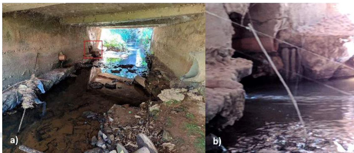
Figura 181 – Córrego do Mosquito no ponto do canal 2. a) Vista debaixo da ponte; b) Ligação entre o sistema de esgoto e drenagem
