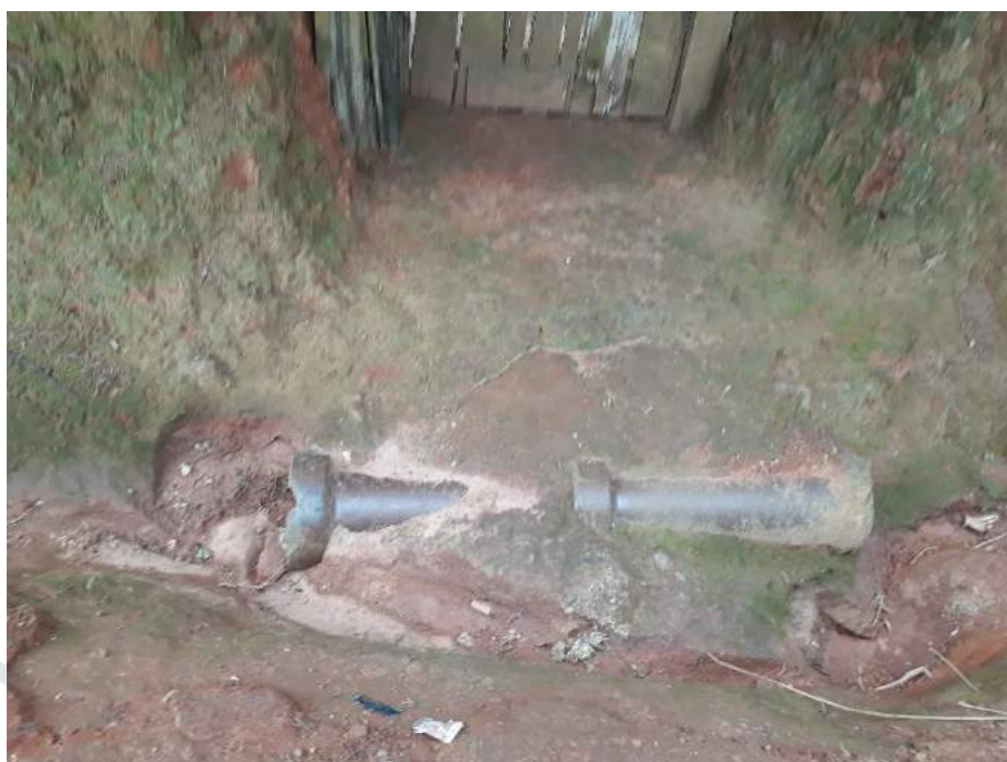
Figura 222 – Estruturas de drenagem na estrada rural de Santa Rita do Sapucaí, MG
