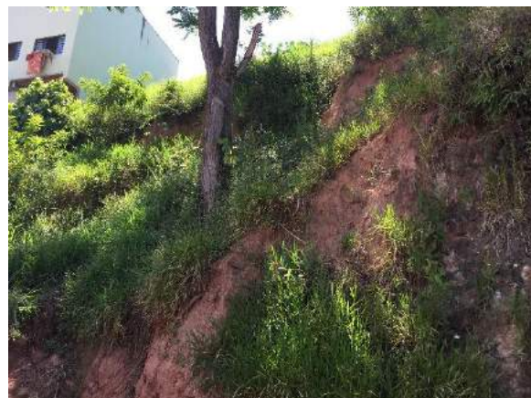
Figura 205 – Área de risco 2 em Santa Rita do Sapucaí
