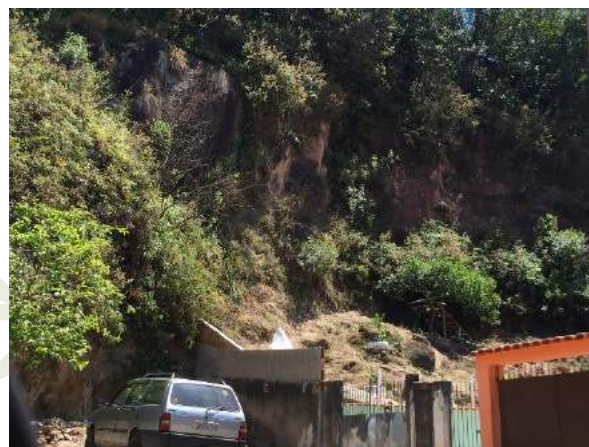
Figura 210 – Área de risco 5 em Santa Rita do Sapucaí
