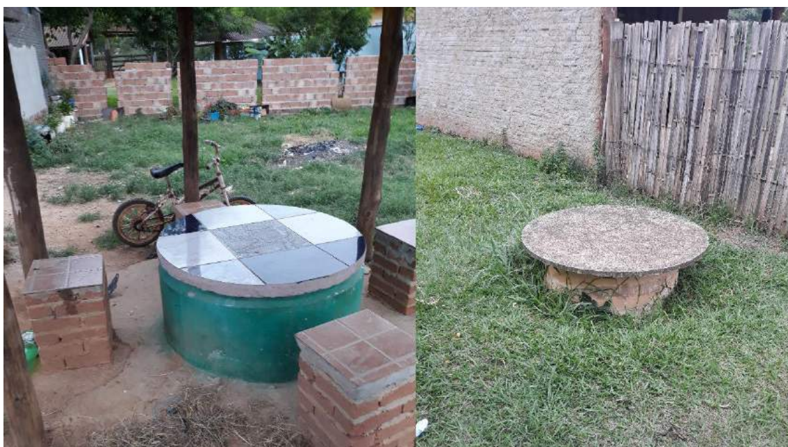
Figura 216 – Poço cacimba para abastecimento de água na zona rural de Santa Rita do Sapucaí, MG
