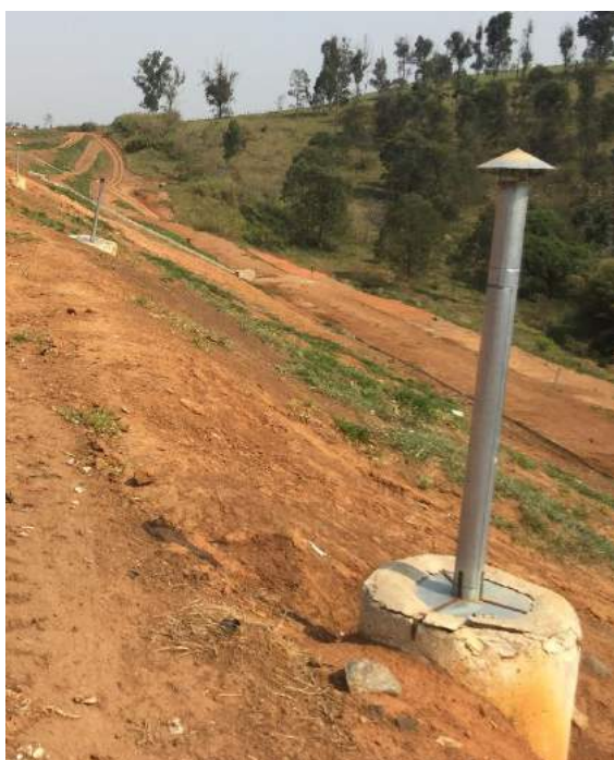
Figura 139 – Chaminé Fonte: Próprios autores, 2019
