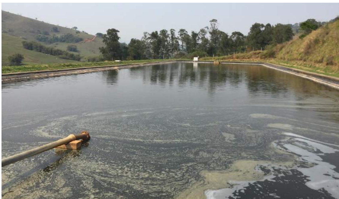
Figura 141 - Lagoa de tratamento Fonte: Próprios autores, 2019
