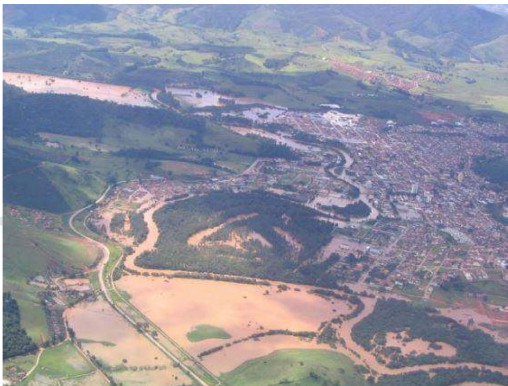
Figura 156 – Vista parcial do município de Santa Rita do Sapucaí na cheia de 2007
