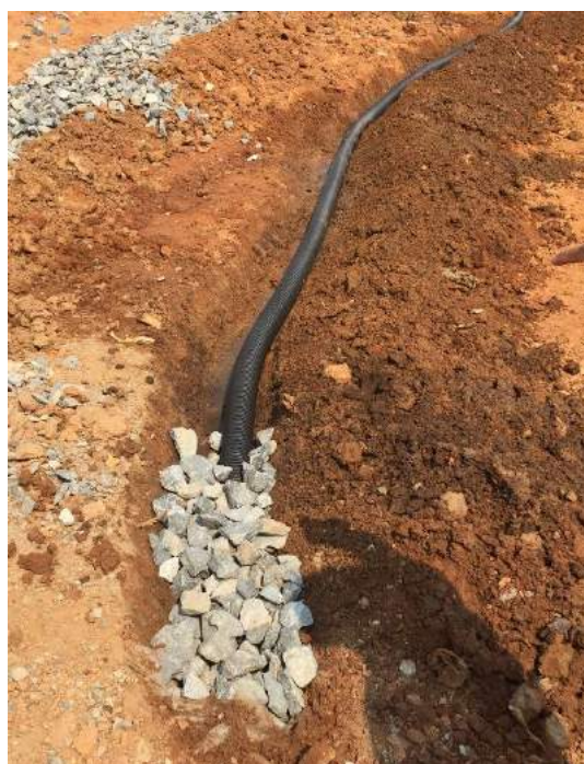
Figura 140 - Instalação de drenos devido ao brotamento de chorume Fonte: Próprios autores, 2019
