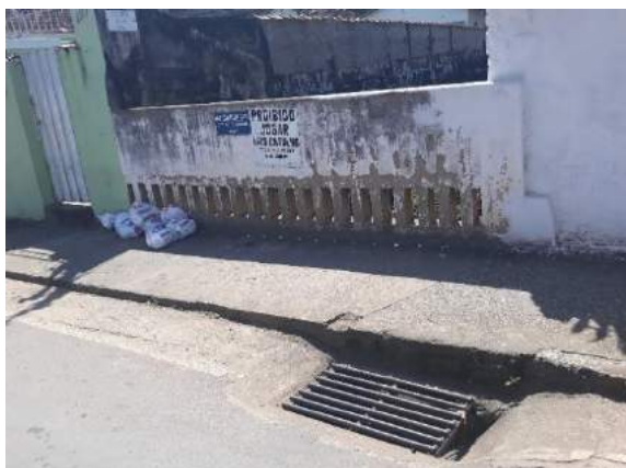
Figura 177 – Vista do início do canal 1 do Córrego do Mosquito Fonte: Próprios autores, 2019
