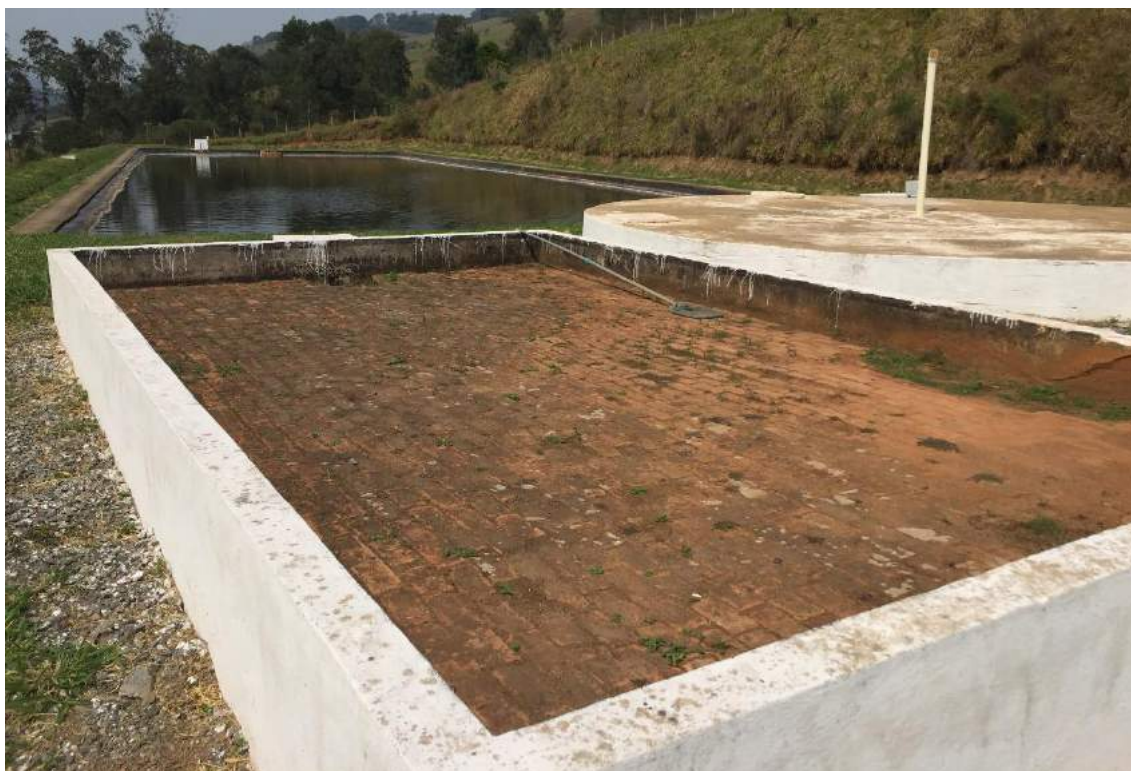
Figura 142 - Leito de secagem
