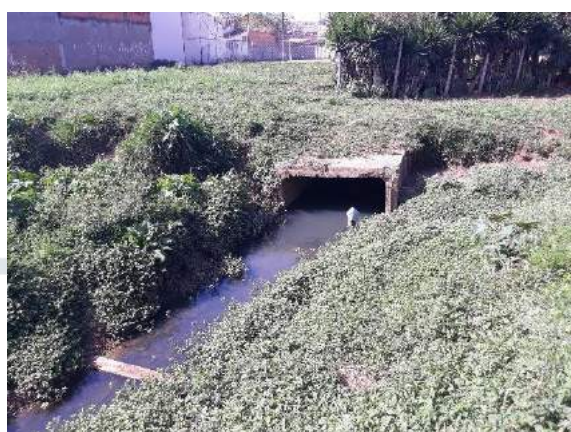
Figura 173 – Vista do córrego canalizado a céu aberto, saindo da canalização
