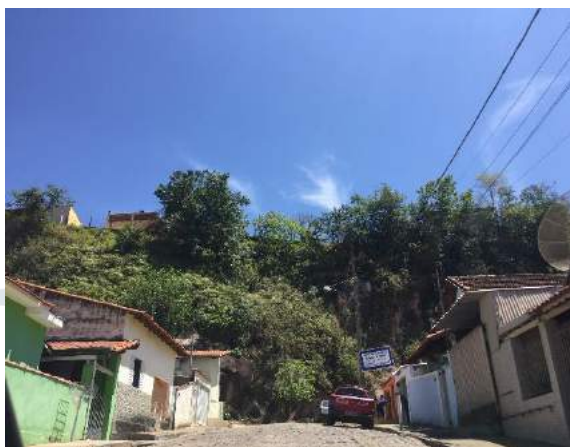
Figura 209 – Área de risco 5 em Santa Rita do Sapucaí
