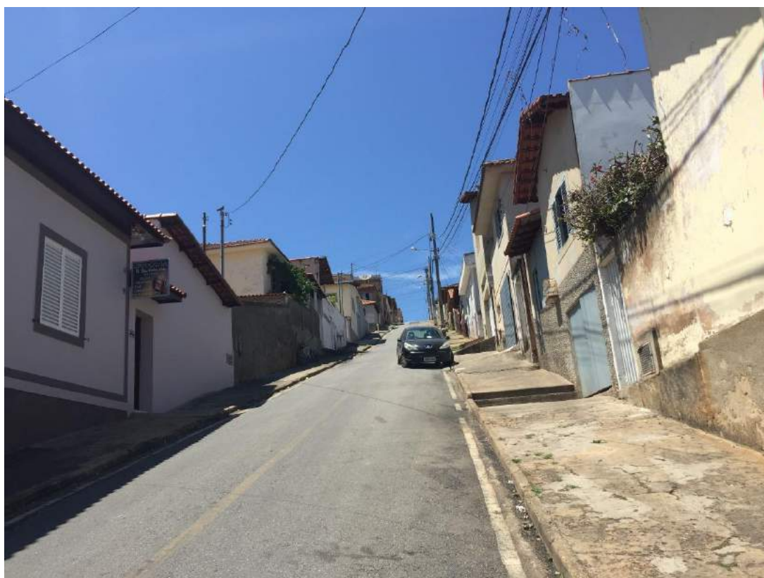
Figura 208 – Área de risco 4 em Santa Rita do Sapucaí
