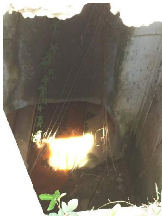
Figura 176 – Vista de dentro da caixa de drenagem sobre o Córrego Bela Vista Fonte: Próprios autores, 2019
