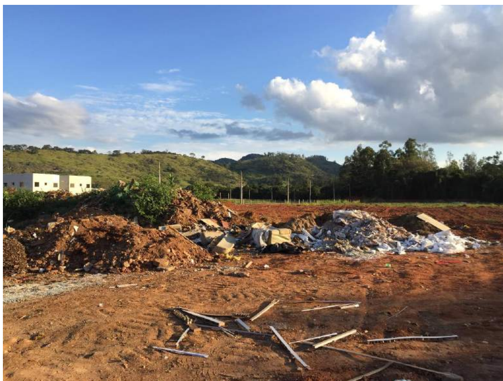
Figura 125 - Resíduos de construção civil com descarte inadequado
