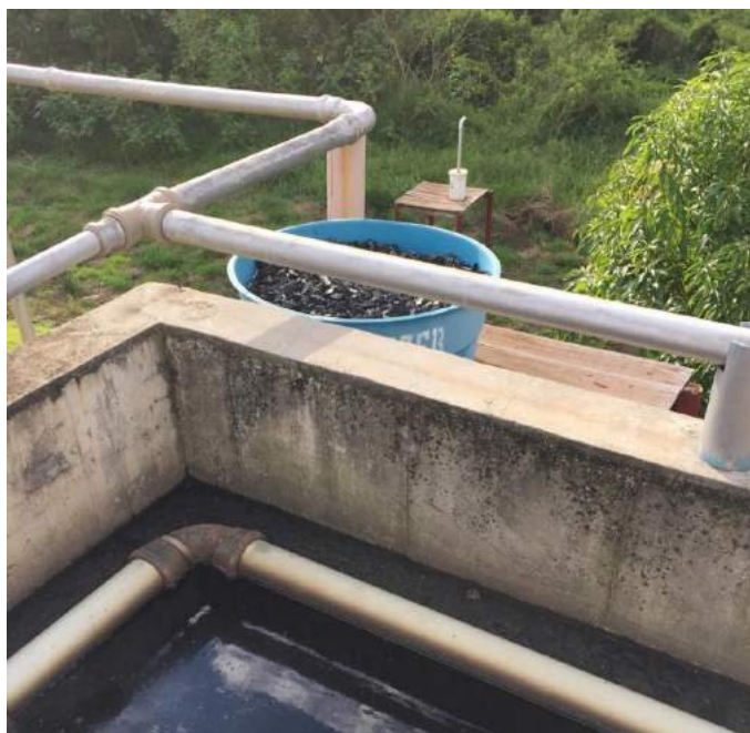
Figura 108 – Filtro de gases no reator
