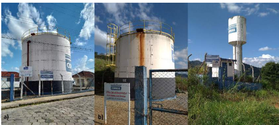
Figura 89 – Vista para os reservatórios em Santa Rita do Sapucaí. a) R9, b) R10, c) R13 Fonte: Próprios autores, 2019
