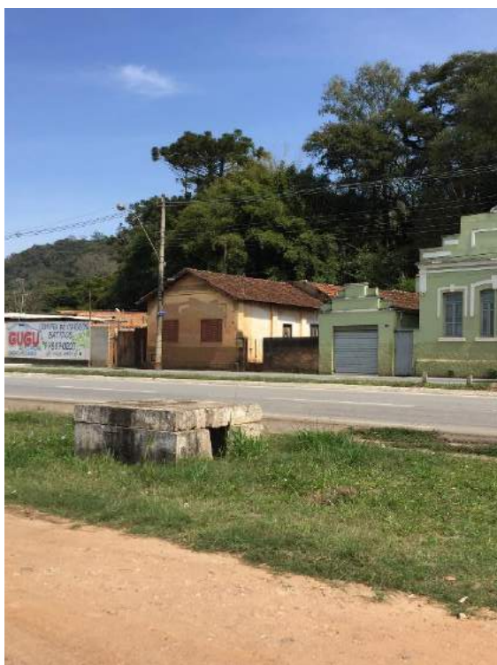
Figura 175 – Vista da caixa de drenagem sobre o Córrego Bela Vista Fonte: Próprios autores, 2019
