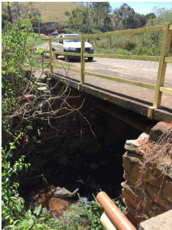
Figura 167 – Vista da Ponte 3 sobre o Córrego do Mosquito
