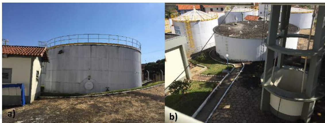
Figura 85 – Reservatórios da ETA em Santo Antônio. a) R1, b) Vista para o R1, R5, R6 e R7
