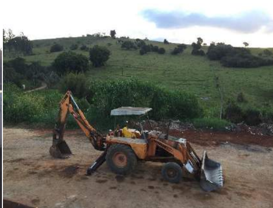
Figura 128 - Máquina Retroescavadeira Fonte: Próprios autores, 2019
