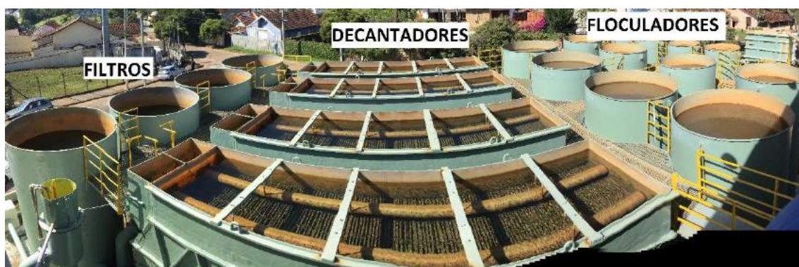
Figura 76 – Estação de tratamento de água Santo Antônio, etapa de clarificação da água Fonte: Próprios autores, 2019
